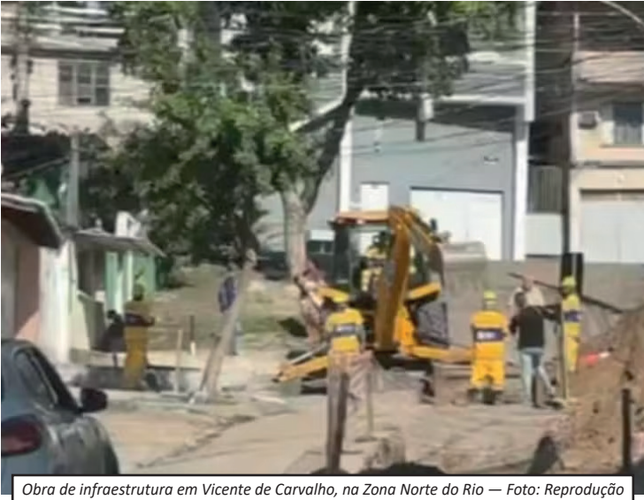
Obra de infraestrutura em Vicente de Carvalho, na Zona Norte do Rio — Foto: Reprodução
