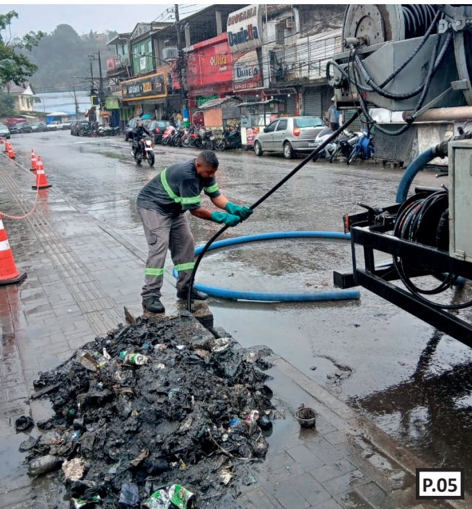
Prefeitura de Japeri realiza limpeza de ralos em Engenheiro Pedreira
