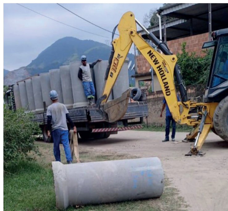
Intervenções vão beneficiar moradores com mais de 2,2 quilômetros de pavimentação, melhoria no escoamento das águas pluviais e mais qualidade de vida para a população - Foto: Divulgação
