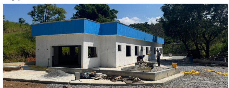
Com mais de 80% das obras concluídas, unidade representa investimento superior a R$ 1 milhão e vai garantir atendimento mais próximo e digno para a população - Foto: Divulgação
