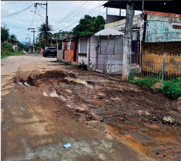
Após reparo mal concluído da Águas do Rio, buraco cresce e caminhão do lixo não passa no bairro Amendoira em São Gonçalo - Foto: Reprodução/Setembro2025/Folha do Pacheco
